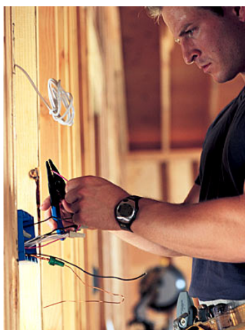
ภาพที่ 1.5 การตรวจสอบสายไฟฟ้า
