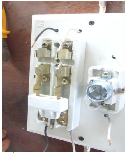
13) ติดตั้งปลั๊กไฟหรือไฟสวิตช์
