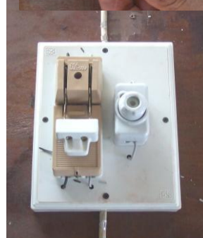
22) การติดตั้งคัตเอาต์เสร็จสมบูรณ์
