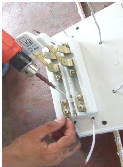
12) ติดตั้งคัตเอาต์ตรงตำแหน่งที่หมายไว้
