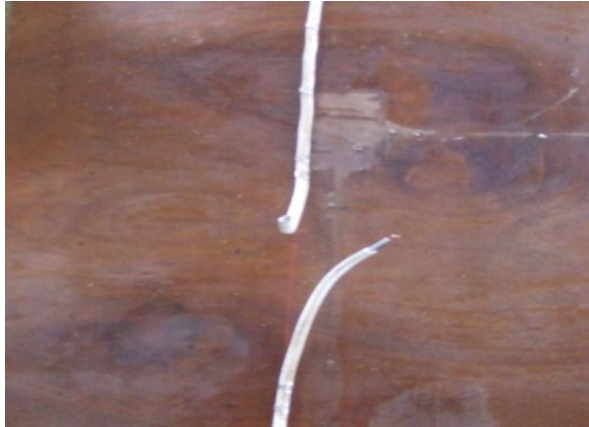
1) เดินสายจากแหล่งจ่ายเข้าคัตเอาต์และจากคัตเอาต์จ่ายให้วงจรไฟฟ้าในบ้าน
