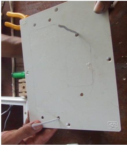
9) ลากสายเชื่อมระหว่างคัตเอาต์ไปหาปลั๊กไฟวส์
