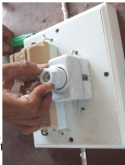
21) ติดตั้งปลั๊ก
