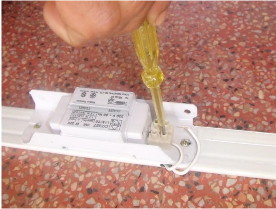
3) ติดตั้งปลั๊กยึดอยู่บนราง ต่อปลายสายทั้งสองข้างเข้ากับขั้วปลั๊กยึดสายและขั้วด้วยไขควงเช็คไฟ
